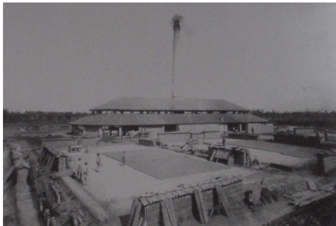
La fornace da laterizi, dotata di forno Hoffmann. [da: Il colore dei ricordi , Ruggiero Marconato (a cura di), Padova, 2004]
