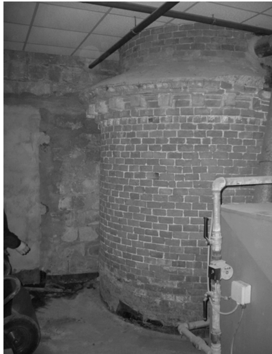
La base della ciminiera, oggi inglobata in un locale di servizio. È notevole il fregio che circonda la base cilindrica, espressione della cura che nei tempi andati si poneva anche nella costruzione delle strutture industriali.
