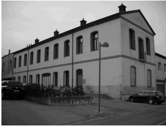
Vista esterna del fabbricato a suo tempo parte della filanda.
