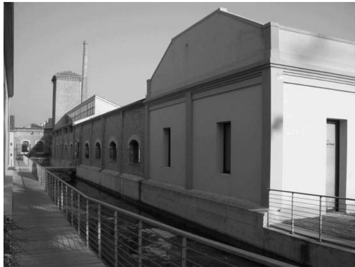
Il ramo della Roggia Contarini che serve lo Jutificio, dopo la ristrutturazione.
