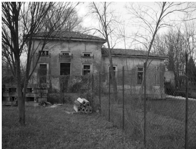
La centrale idroelettrica Garibaldi ai nostri giorni, in stato di abbandono.
