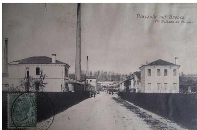
Vista da sud di via Rolando da Piazzola. All'estrema sinistra la primitiva ciminiera dello Jutificio, oltre a quella tuttora esistente, che risale al 1903. La foto è evidentemente stata fatta subito dopo la costruzione della centrale termica del 1903 e prima che il camino della vecchia venisse abbattuto. [per concessione Prof. Pin]
