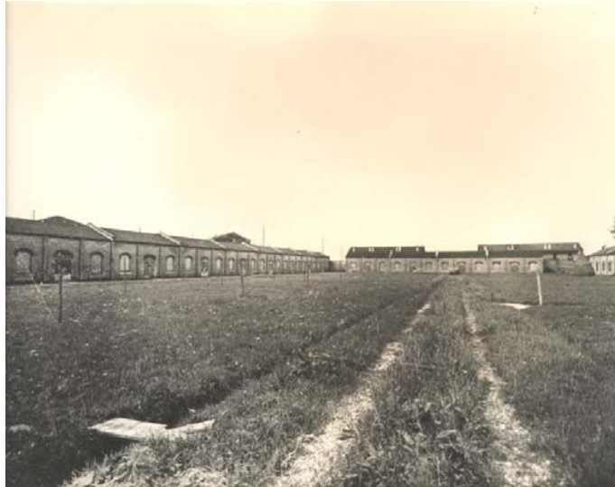
La grande corte dei magazzini dello Jutificio ad ovest di Viale Silvestro Camerini, risalente agli ampliamenti degli anni '20 del Novecento. [Archivio Arch. Negrin & Fauro]
