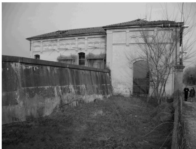
La centrale idroelettrica degli Opifici come si presenta ai nostri giorni. Il muro a sinistra è il fianco della parte pensile della roggia Contarini.
