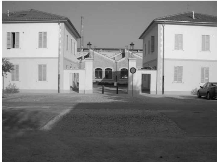
L'ingresso allo Jutificio, dopo ristrutturazione.
