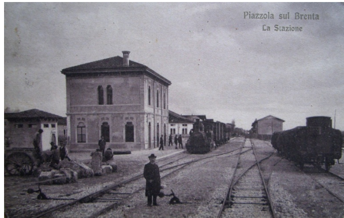
La prima Stazione ferroviaria di Piazzola poi dismessa in occasione del prolungamento della ferrovia fino a Carmignano di Brenta. Il fabbricato si conserva tuttora praticamente integro, trasformato in abitazione civile. [per concessione Prof. Pin]
