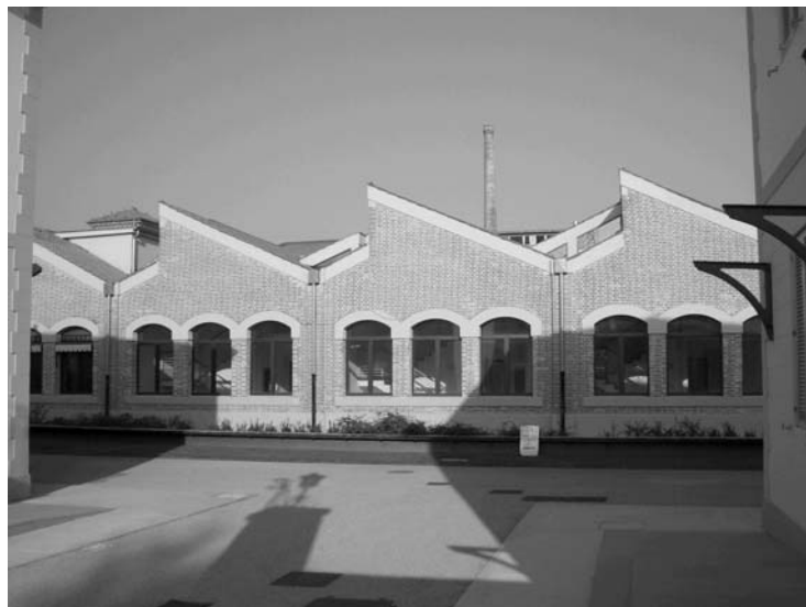
Un fianco dei vecchi reparti ristrutturati.
