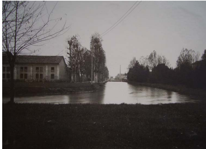
La Roggia Contarini vista da parco della villa. Suullo sfondo lo Stabilimento Concimi, con l'alta ciminiera. [per concessione Prof. Pin]
