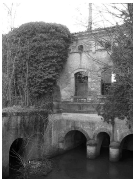
Il canale di scarico della centrale Rolando, ai nostri giorni.
