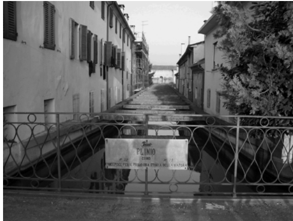
Il ponte canale in cui è convogliata la Roggia Contarini con sullo sfondo la Centrale Opifici. Ai suoi lati gli edifici già adibiti ad attività manifatturiere (mulini, maglio, follo, pila da riso, ecc.)
