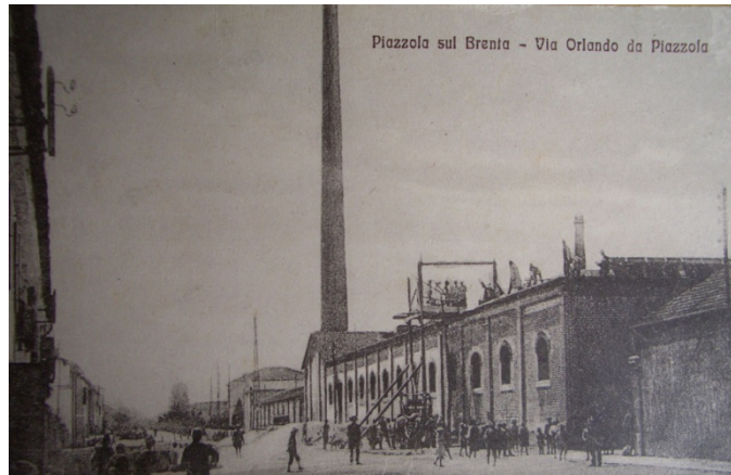
Lo Jutificio visto da via Rolando da Piazzola, probabilmente durante i lavori di ampliamento del reparto filatura. [per concessione Prof. Pin]
