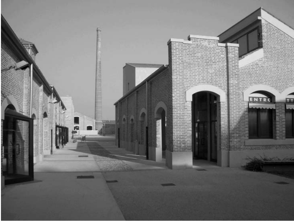
Lo Jutificio ristrutturato. Sullo sfondo il locale caldaie con al fianco la ciminiera.
