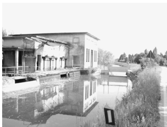
La centrale idroelettrica di Isola, da monte.
