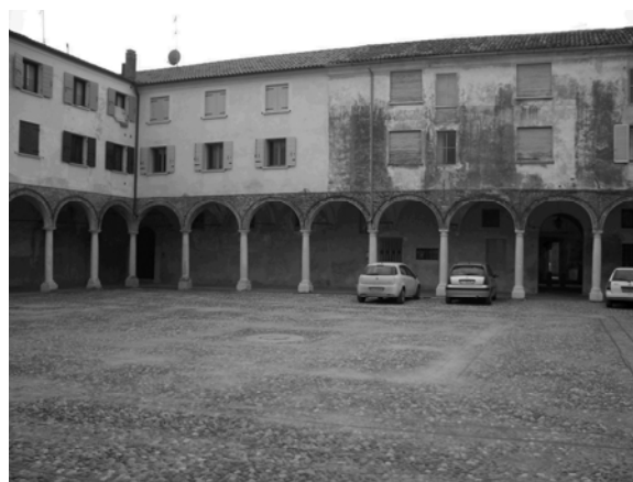
Il Chiostro delle vergini poi trasformato in cortile della filanda. Abbastanza conservato il portico a piano terra; completamente trasformate le sequenze delle finestre al primo e secondo piano.
