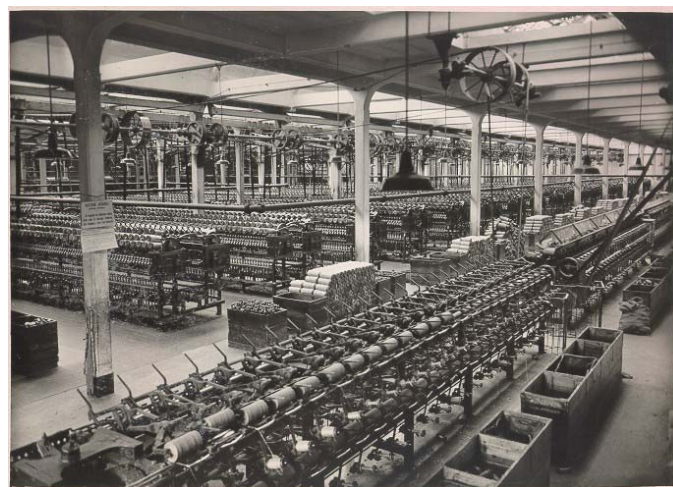
Il Reparto filatura nuovo a nord del ramo della roggia che lo sotto passa, dopo l'ampliamento del 1916. [Archivio Arch. Verdi]
